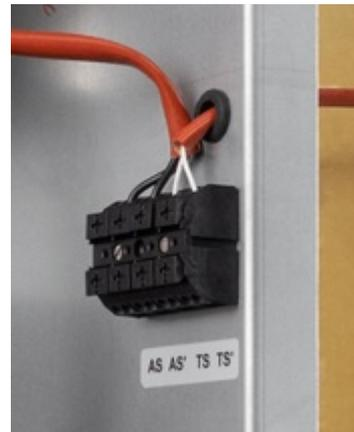
Figure 31 borne pour la connexion de contact auxiliaire
