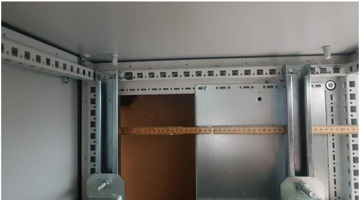
Figure 7 ouverture dans le fond de l'armoire (vue de dessus depuis l'intérieur). Environ 1/3 d'ouverture restante.
