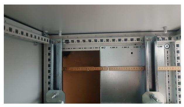
图7机柜底部的开口(内部俯视图)。 大约有保持打开 1/3 的状态。
