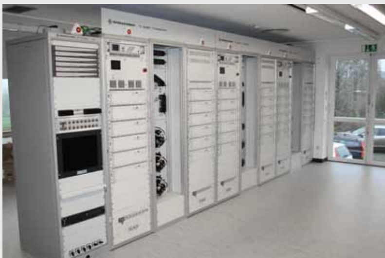
Teil einer DVBT-Sendeanlage
